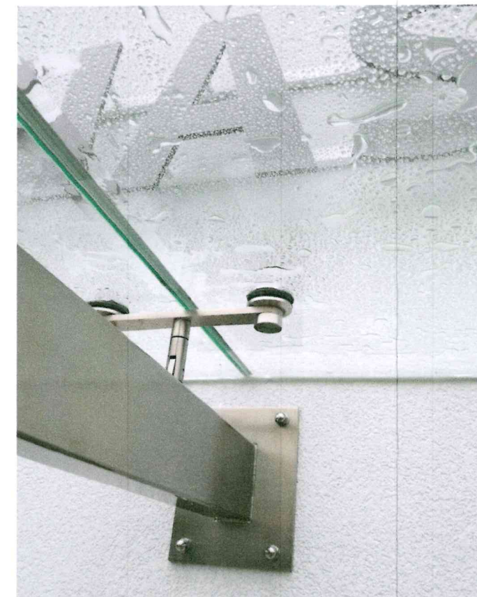
WIDOK ZAMOCOWANIA BELKI
